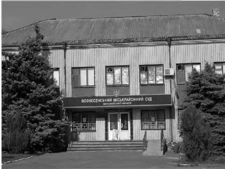
Рис. 3.1. Будівля Вознесенського міськрайонного суду Миколаївської області
